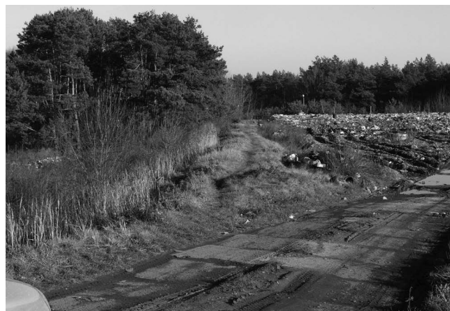
Rys. 7. Przykład składowiska odpadów Borszowice – widok na zdeformowane obwałowanie składowiska (fot. Kwiatkowski, 2009)
