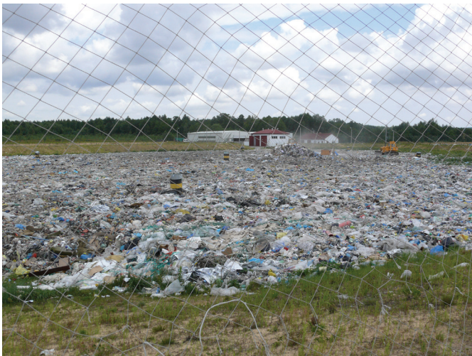
Rys. 4. Przykład składowiska odpadów w Janczycach spełniającego wymagania przepisów o odpadach, wybudowane po audycie (fot. Kwiatkowski 2010)
