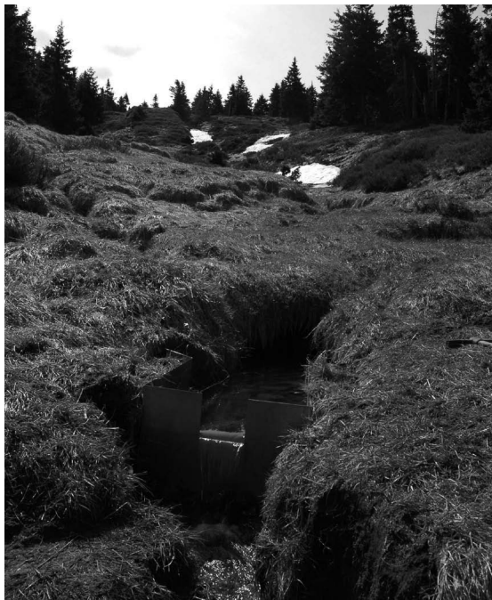
Fot. 1. Przelew prostokątny na źródle w okolicy Hali Szrenickiej Photo 1. Rectangular overfall on the spring in the Hala Szrenicka vicinity
