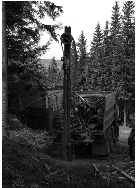
Fot. 2. Wiercenie piezometrów w rejonie nartostrady Puchatek Photo 2. Drilling of piezometers near the Puchatek ski downhill
