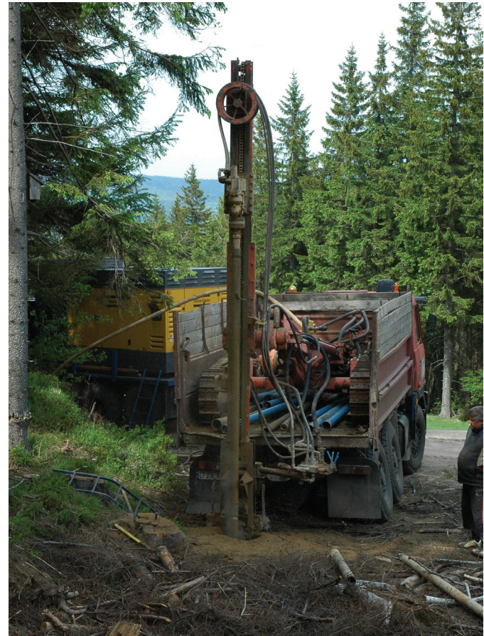
Fot. 2. Wiercenie piezometrów w rejonie nartostrady Puchatek Photo 2. Drilling of piezometers near the Puchatek ski downhill
