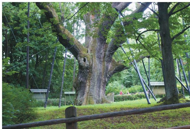
Fot. 3. Konstrukcja podtrzymująca konary dębu (fot. S. Dzikowski) Photo 3. The construction supporting the branches of the oak (photo S. Dzikowski)
