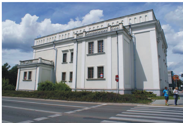
Fot. 11. Synagoga, stan obecny (fot. S. Dzikowski) Photo 11. Synagogue – the current state (photo S. Dzikowski)
